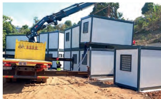
Chantier 21 logements de Massimoni - MJ.Koropa avec récupération d'eau pluviale
