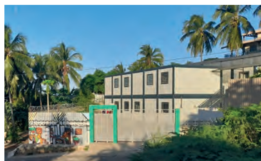
10 logements modulaires d'Hamachaka - MJ.Koropa
