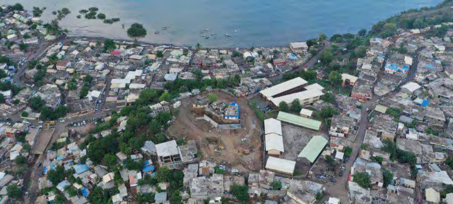
Vue aérienne du talus Majicavo après démolition du bidonville, DroneGo
