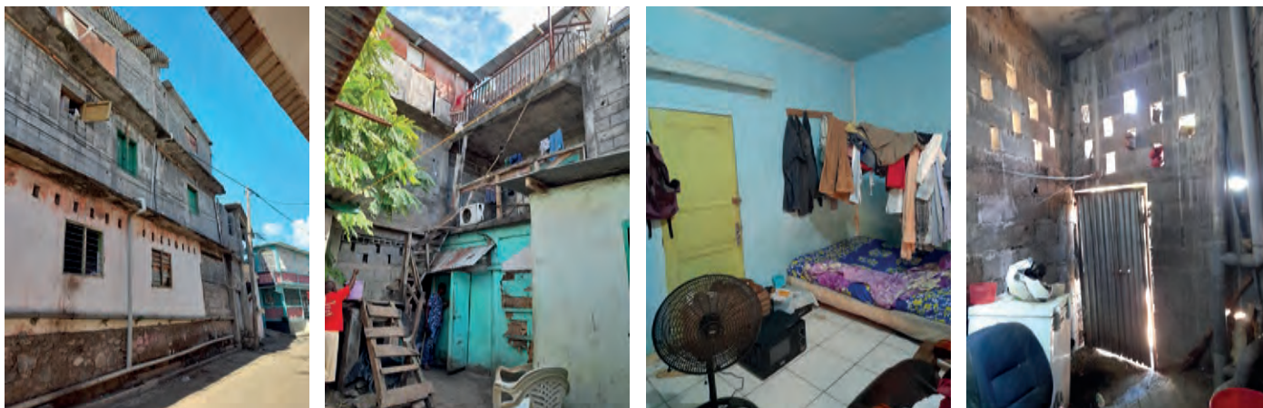
Rue Chehoullah, Majicavo-Koropa (« Maison des Africains ») - 70 personnes dans un bâtiment menaçant ruine
