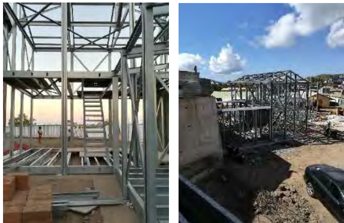
Photos du chantier en cours, septembre 2020
