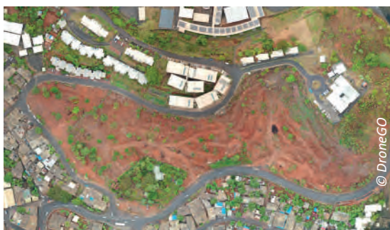
Après démolition - octobre 2021
