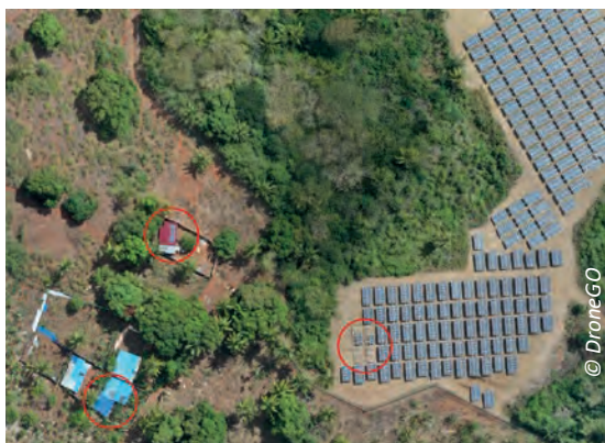
Parc photovoltaïque de Longoni avec panneaux manquants...
