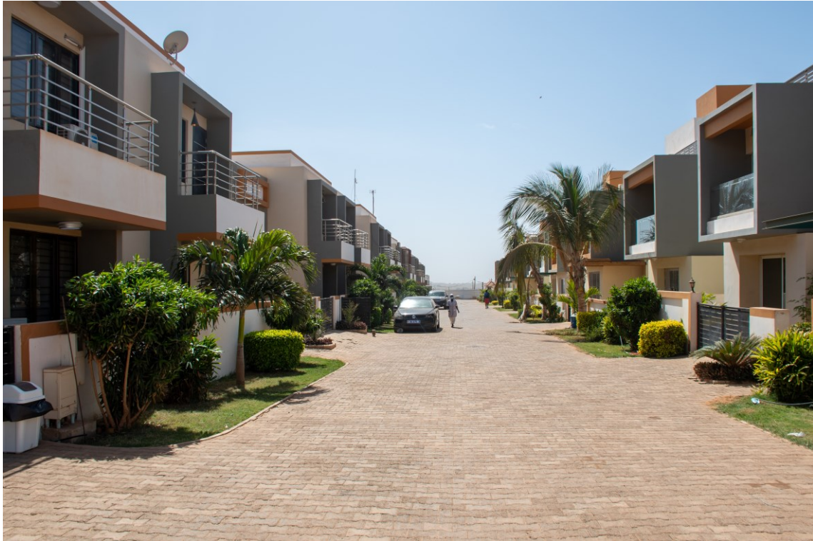
Figure 114. Des villas dans la cité résidentielle
