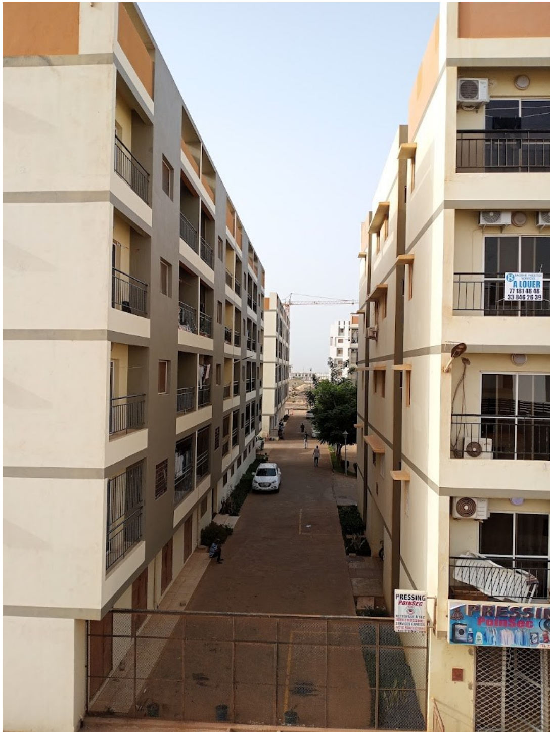
Figure 91. Immeuble d'habitation climatisé dans la cité résidentielle Senegindia Les blocs de climatiseurs envahissent très souvent les façades des immeubles.
