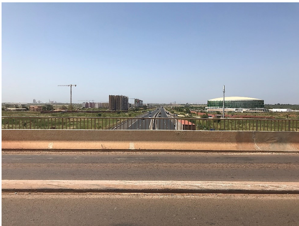
Figure 47. Une vue sur l'autoroute Dakar-Diamniadio-AIBD depuis l'axe 70
