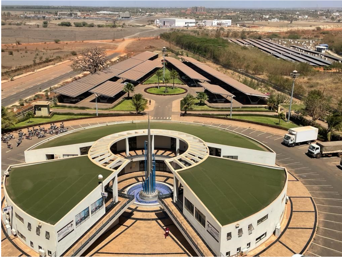
Figure 93. Panneaux photovoltaïques de la sphère ministérielle du secteur 1 Les panneaux servent également de toit pour le parking. À droite de la photo, à l'arrière-plan, les panneaux du centre de conférences.
